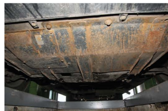
▲ Моторный отсек бережет защита из сплошного листа металла
