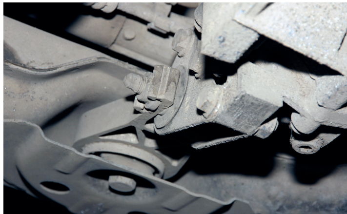
▲ В демпфере, расположенном на балке передней подвески задней опоры силового агрегата, не должно быть трещин и разрывов
